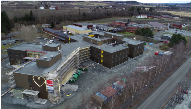
Verdal Bo- og behandlingssenter under bygging (foto Roger Eggen, Veidekke)
